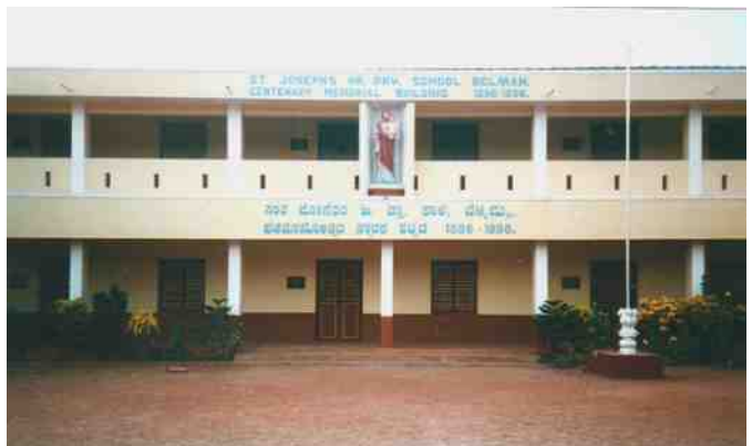
Grundschule im Schulkomplex "St. Joseph"
