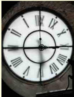
sanierte Kirchturmuhre St. Josef © M. Schrammek
