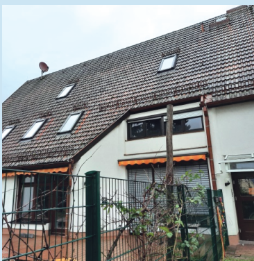
Altbau Kita in St. Konrad altes Dach soll saniert werden
